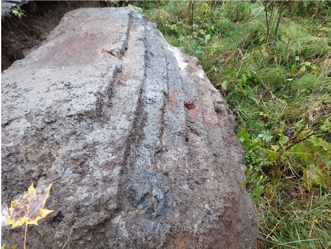
Kuva 4 KK3 Iso betonipala (5.10.2023)
